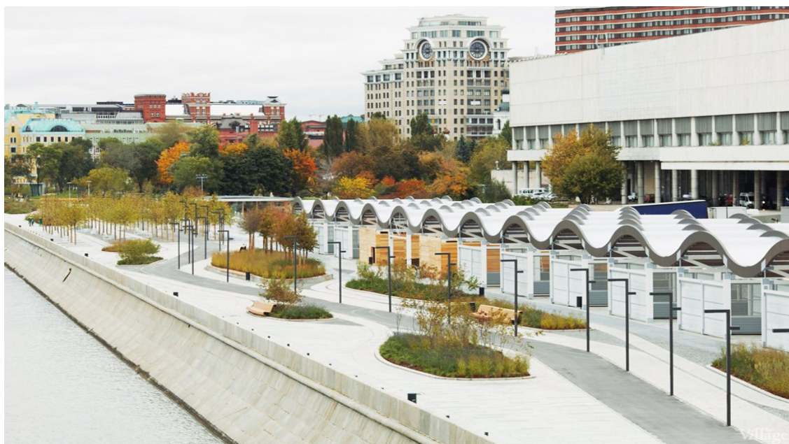
Рис.2. Крымская набережная после реконструкции (фото Ю. Бражникова) Fig.2. Crimean embankment after reconstruction (photo by Y. Braznikov)
