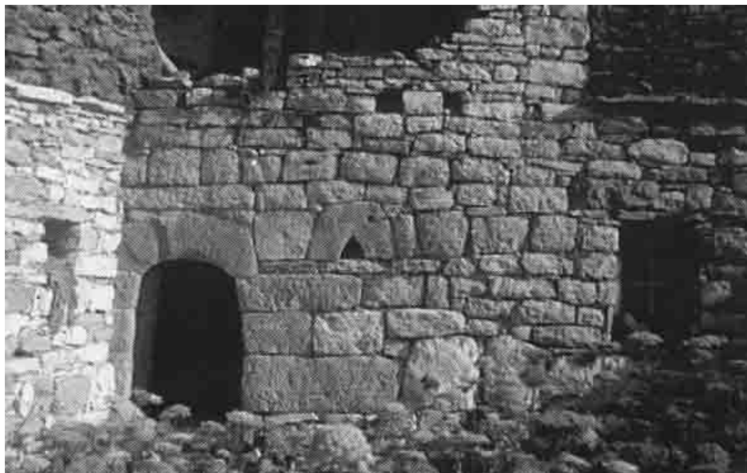
Рис. 1. Сохранившаяся стена дома
